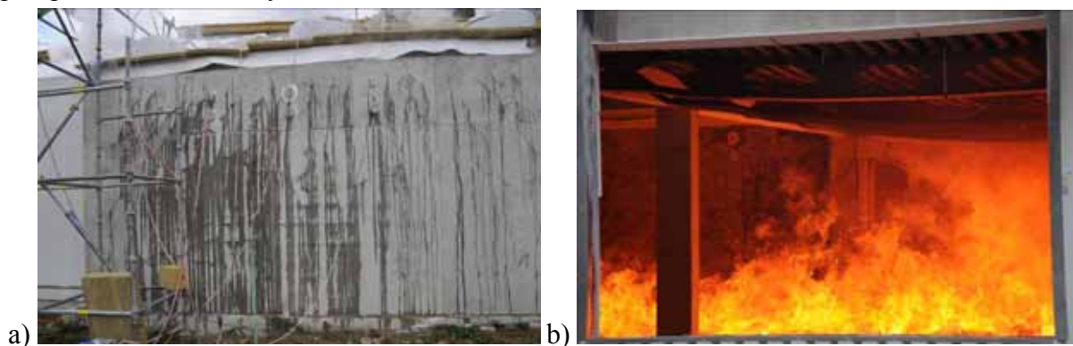
Obr. 16 Betonová stěna při zvýšené teplotě a) vylučování vody na vnější straně, b) oprýskávání betonu na vnitřní straně
